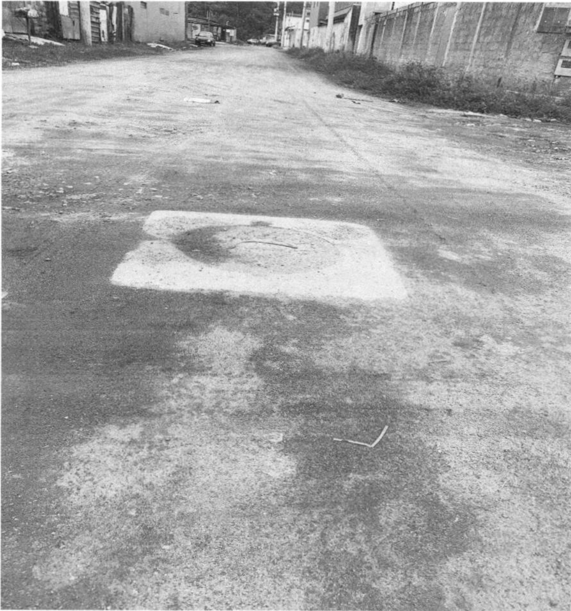
DESENTUPIMENTO DA REDE DE ESGOTO NA RUA ANTÔNIO MANOEL LINO DA SILVA COM O CRUZAMENTO DA RUA CEILÃO.
